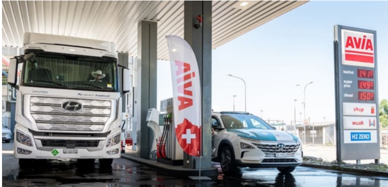
Wasserstoff-Tankstelle St.Gallen im Oktober 2020
